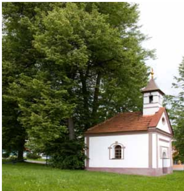
2. Kaple sv. Anny na návsi v Krtelích. Severozápadně od obce se nacházejí v rozsáhlém krtelském lese mohylová pohřebiště z pravěku a doby slovanské.
