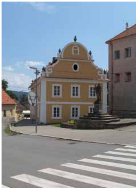
8. Stará radnice ve Lhenicích, stav 2009, foto Pavel Fencl.
